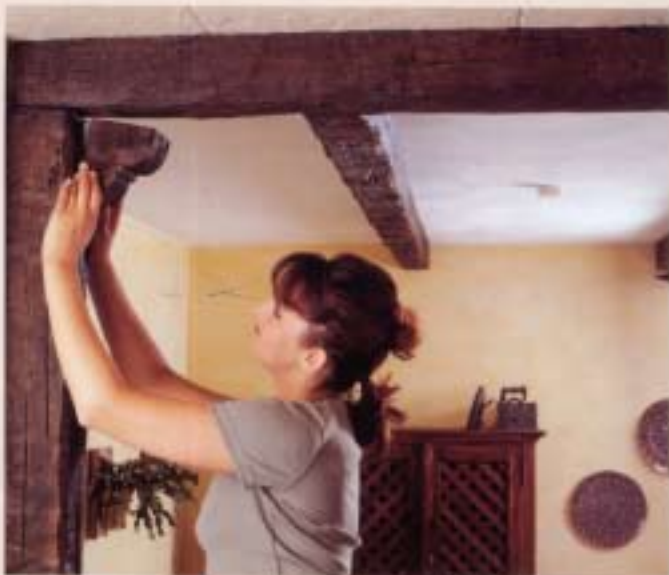
Последними монтируются консоли. Соединения могут б ыть скрыты оконкой или мастикой/морилкой
