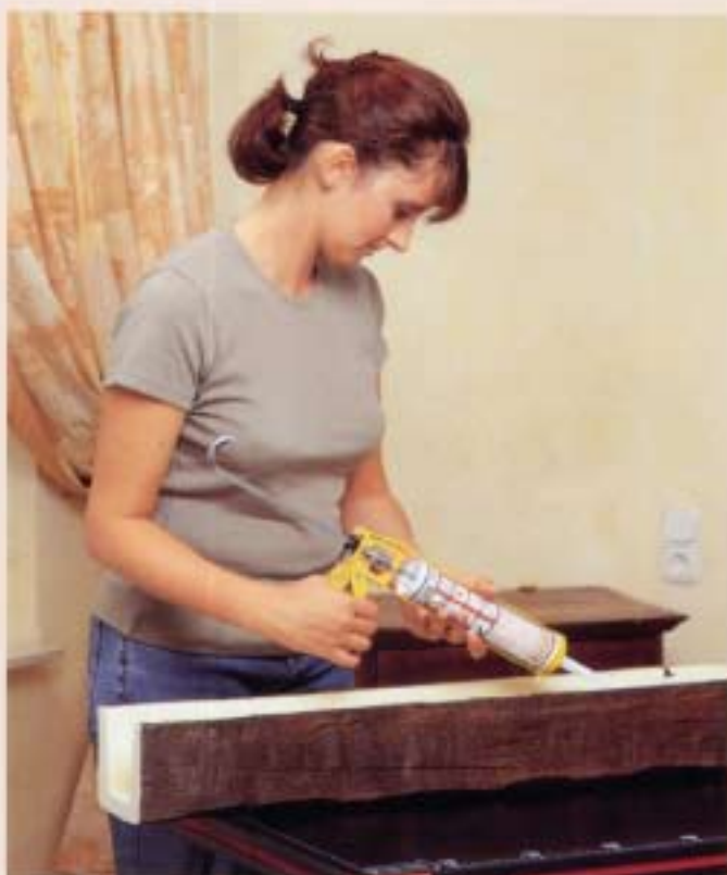
клей нанести на обратную сторону балки. одной картриджи универсального клея DECOSA достаточно прим. для 10 м. балок
