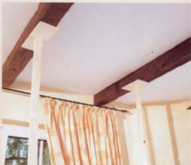
Балку на несколько часов подпереть.
